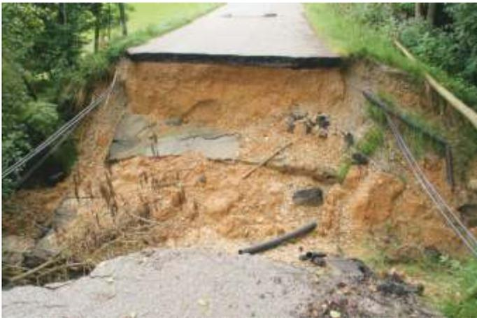
Ein tiefer Krater ist entstanden, wo früher eine Teerstraße bei Kothöring über den Bach führte. Es muss ein neues Wellenrohr eingesetzt, das ganze wieder mit Kies aufgefüllt und mit einer neuen Teerdecke versehen werden. Solange müssen einige Anwohner weiterhin große Umwege fahren zur Arbeit bzw. nach Wittibreit zu gelangen. Ein anderes beschädigtes Teilstück der Straße bereits wieder repariert.
