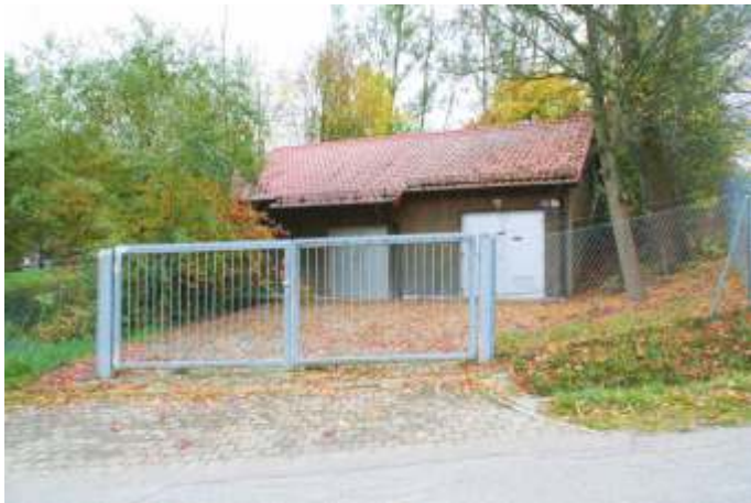
Das Pumpenhaus neben der Gemeindestraße nach Kienberg, von hier kommt unser Trinkwasser.
