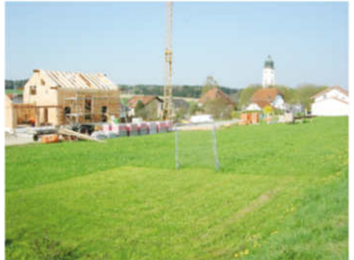
Nichts zu tun für Manuel Neuer: Baugebiet „Pfarrweg Ulbering“
