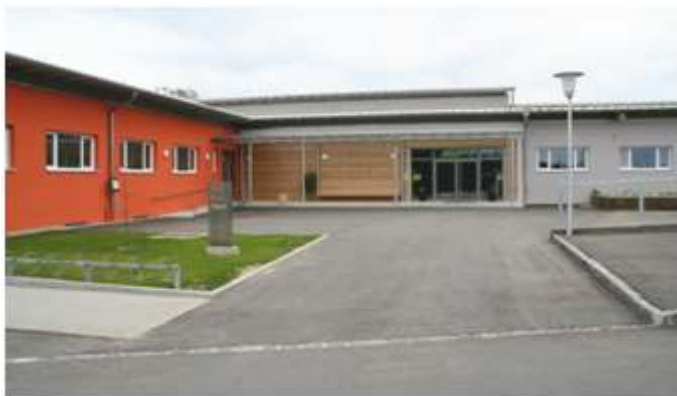
Die Sanierung der Grundschule war die größte Baumaßnahme.
