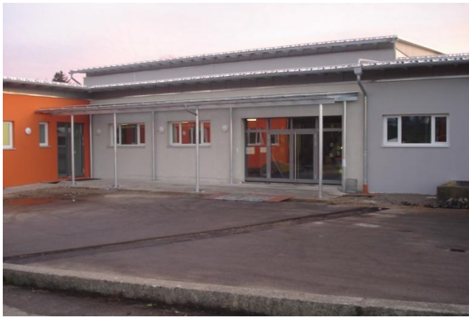
Neu gestalteter Eingangsbereich mit Überdachung
